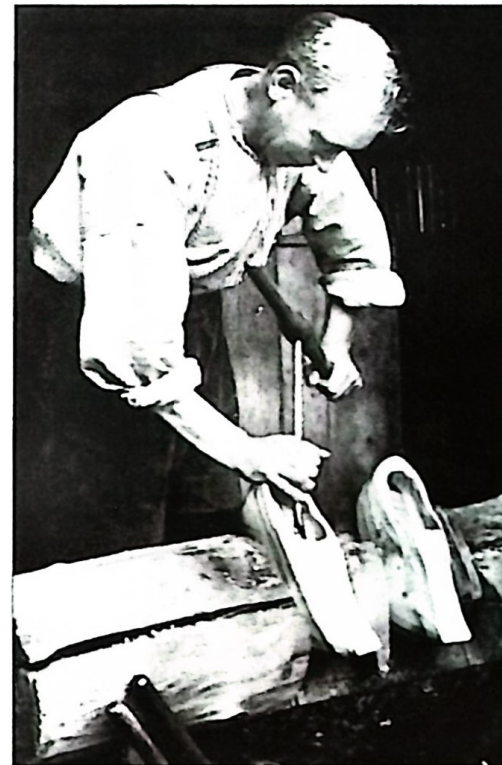
BEIM AUSBOHREN der Holzschuhe, Foto: Klompenmuseum Hogebrink 4, 7468 CB Enter
