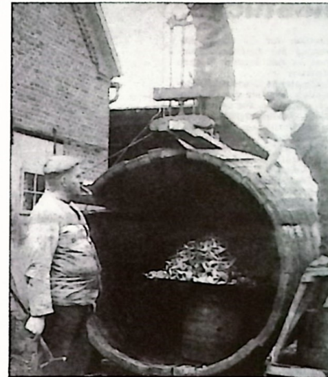
DER ENTSCHEIDENDE ARBEITSGANG: Das Einpassen der letzten Fassdaube unter Druck mit Hilfe eines Drahtseils: Auf dem Bild die Böttchermeister Bernhard Plöger (links) und Hermann Plöger (rechts) mit einem Gesellen.
