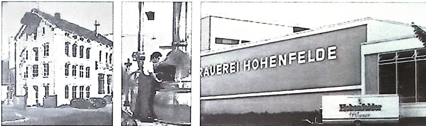
HOHENFELDE HEUTE: links das Sudhaus mit Kupferkesseln, rechts die modernen Betriebsgebäude
